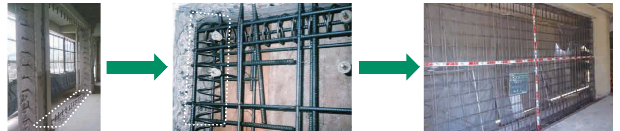
あと施工アンカー筋の打設
