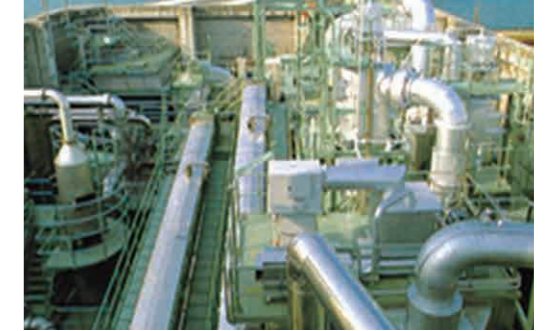
免震化を提案した上下水道施設
