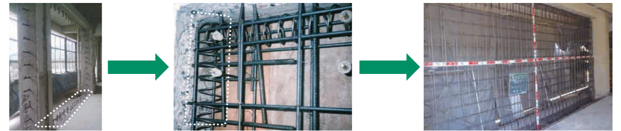
あと施工アンカー筋の打設
