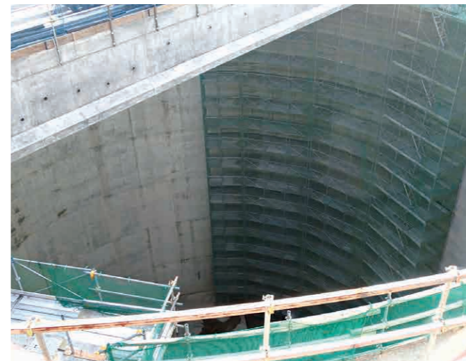
現地調査写真
