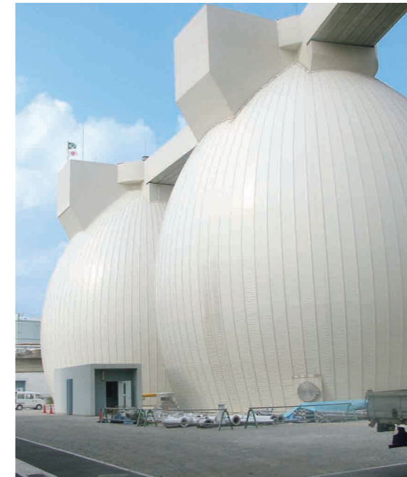
某タンク基礎
