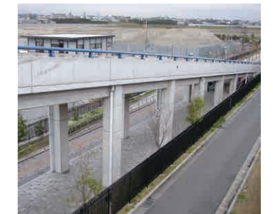
下水処理場上部利用車路(RC造)
