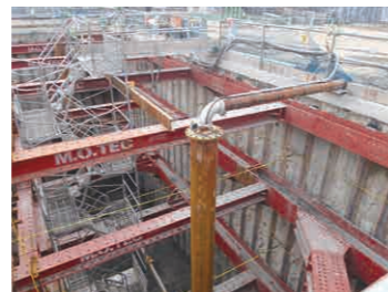
排水工法(ウルトラディープ工法)
