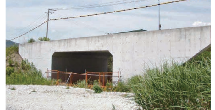
現地調査写真
